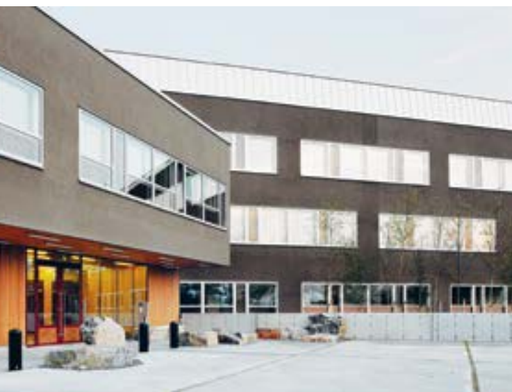
En välkomnande entré för en anläggning med högsta säkerhet. BILD MAXPLUNGER
